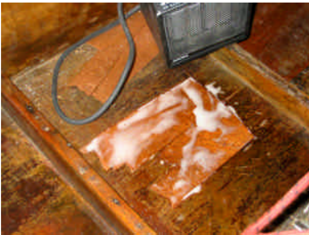
Irtonainen viilu leikattu irti ja epoksiliima levitetty
